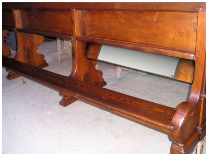
Pannello installato sotto le bancate (versione non stampata)
